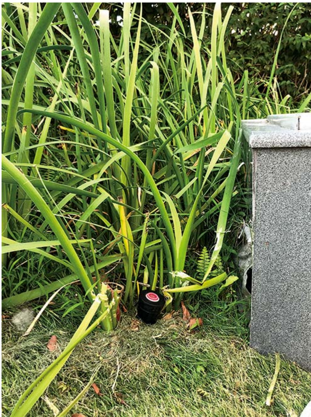
油麻地警署設有雨水循環系統。
