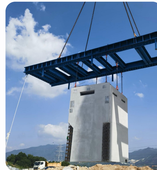
香港警察學院綜合訓練中心（缸瓦甫）的建築工程涉及裝嵌預製組件。
